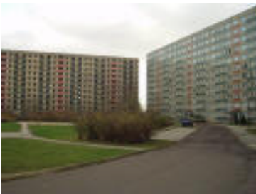
Abb. 3 Leer stehende Wohn-Gebäude in Halle-Süd
