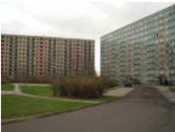
Abb. 3 Leer stehende Wohn-Gebäude in Halle-Süd
